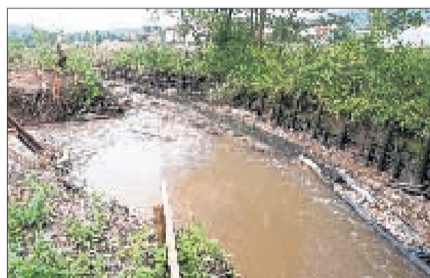
DURCHBRUCH Hier schwemmte das Wasser die Absperrungen weg und floss nach links ins neue Kanalbett. ALF
